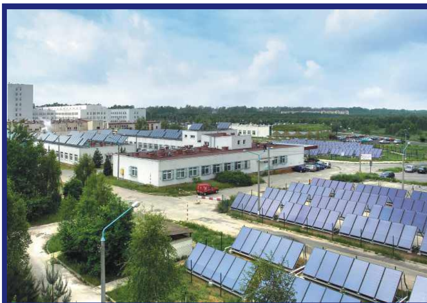
Największa instalacja kolektorów słonecznych w Polsce – Częstochowa
