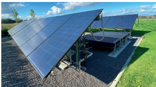
Hybrydowa instalacja kolektorów E-PVT. 20 paneli o łącznej mocy elektrycznej 6,5 kW p i mocy termicznej 17 kW.
