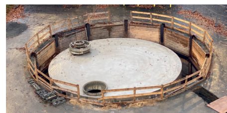
Lodowy magazyn energii w końcowej fazie budowy. Jego pojemność wynosi 350 m 3 .
