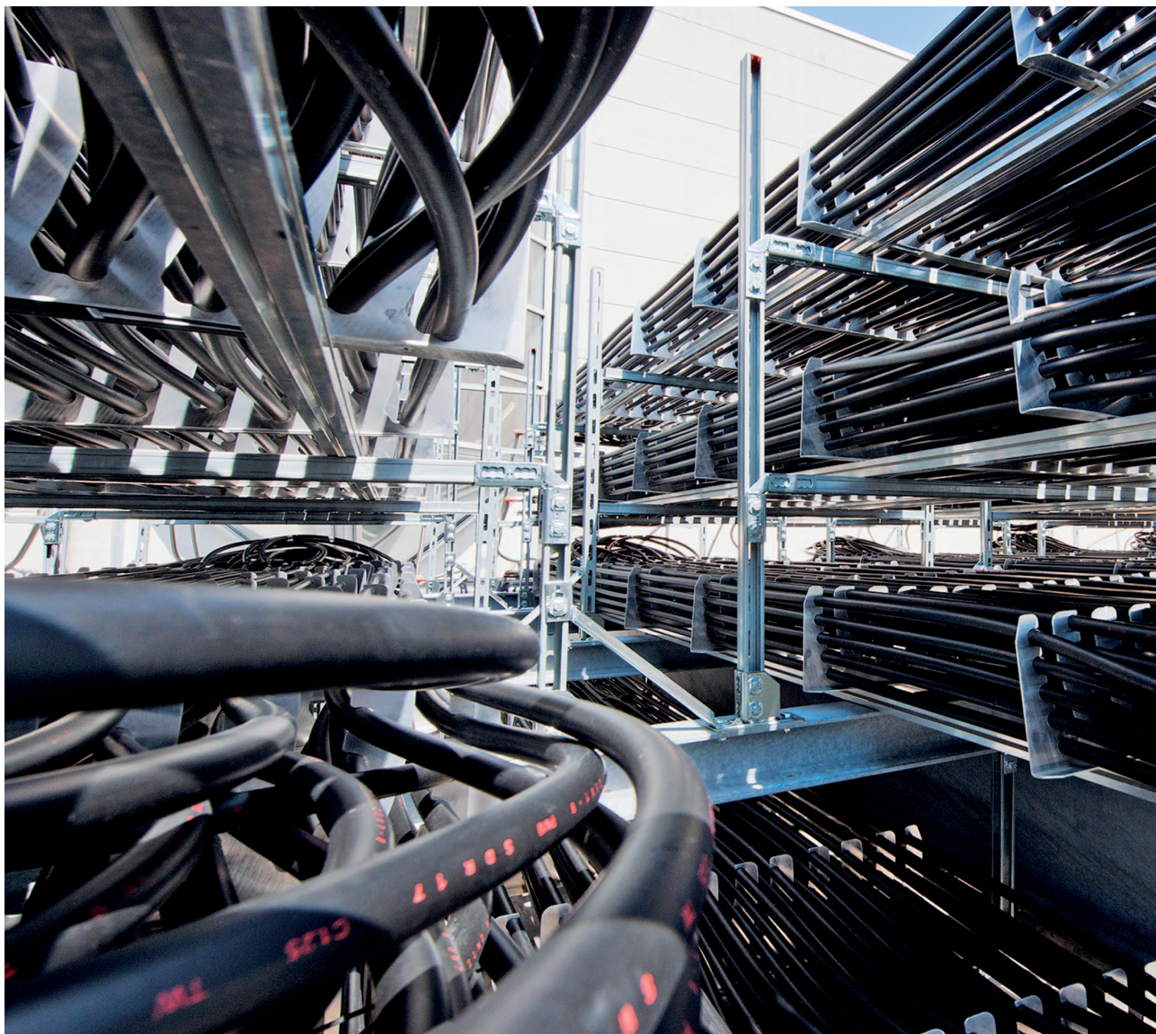
Absorbery solarno-powietrzne pobierają energię z powietrza i promieniowania słonecznego, aby wytwarzać z niej ciepło grzewcze i chłód.
