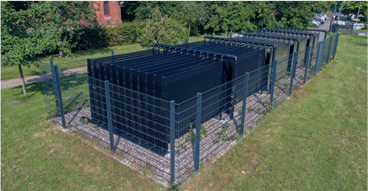
Kompaktywnym rozwiązaniem absorberów solarno-powietrznych jest plot energetyczny.
