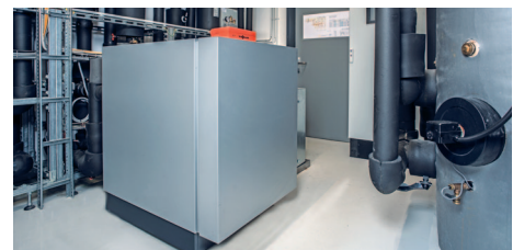
Pompa ciepła Vitocal 300-G Pro o mocy 82,8 kW w nowym budynku starostwa Rendsburg
