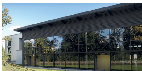
Nagrodzony nowy budynek Centrum Szkół Zawodowych w Mühlendorf z techniką Viessmann.
