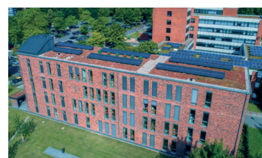
Byłe koszary (u góry) i budynek starostwa w Rendsburgu są zaopatrywane w odnawialną energię z lodowego magazynu energii.
