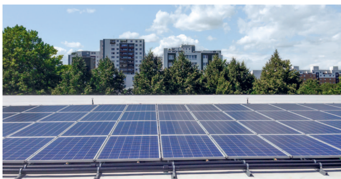
Specjalne moduły kolektorów PVT pozwalają pozyskiwać energię cieplną i elektryczną z tej samej powierzchni dachu.
