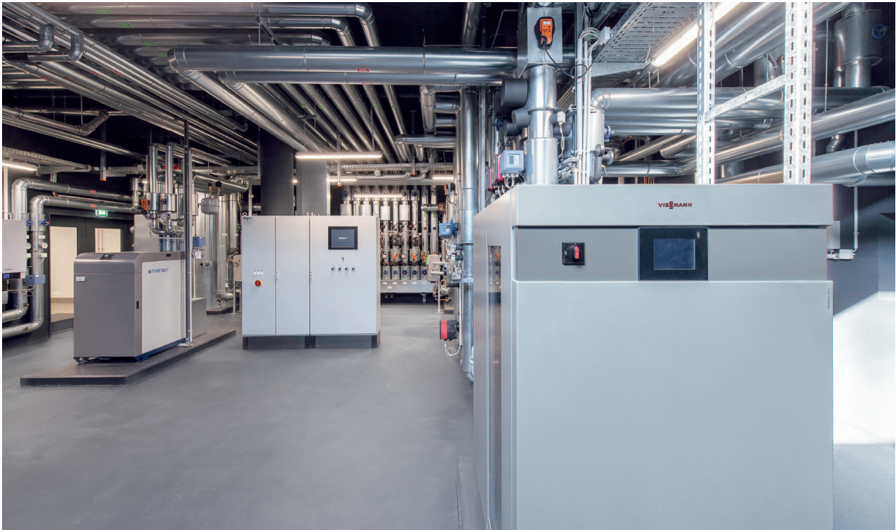
Pompa ciepła dużej mocy Vitocal 300-G Pro ma moc cieplną 82,8 kW.
