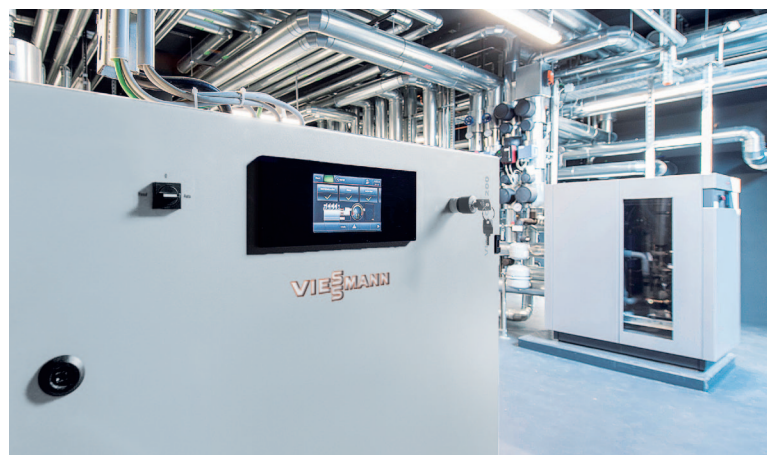
Moduł kogeneracyjny Vitobloc 200 ma moc elektryczną 6 kW el i moc cieplną 15 kW th .
