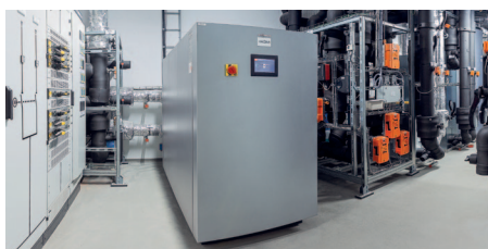
Pompa ciepła Vitocal 300-G Pro o mocy 140 kW
