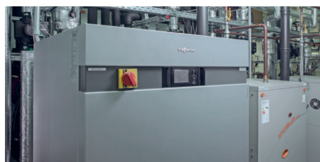
Pompa ciepła Vitocal 300-G Pro o mocy 82,8 kW w nowym budynku starostwa Rendsburg
