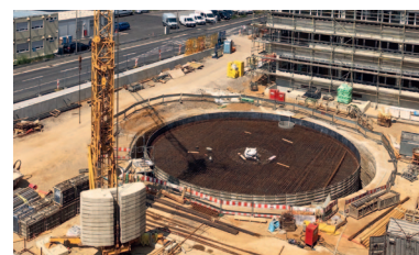
Budowa lodowego magazynu energii o średnicy 10 m
