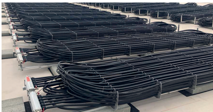
Zainstalowanie na dachu płaskim: absorbery solarno-powietrzne.
