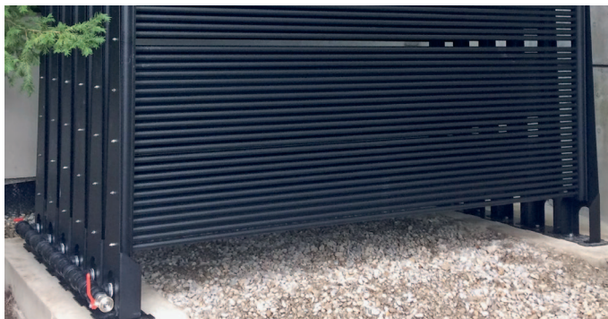
Absorbery solarno-powietrzne w postaci plotu energetycznego. Kompaktowe wykonanie poszczególnych modułów nie wymaga wiele miejsca do ustawienia.
