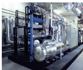
Moduł ORC do wytwarzania energii elektrycznej (opcja)
