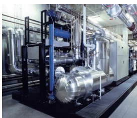
Moduł ORC do wytwarzania energii elektrycznej (opcja)
