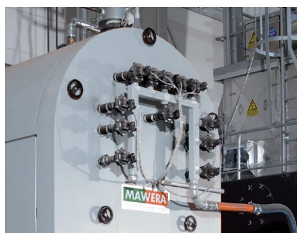
1 System pneumatycznego czyszczenia płomieniówek (wyposażenie dodatkowe)
