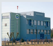
Miejskie Wodociągi i Oczyszczalnia, Grudziądz, Polska
