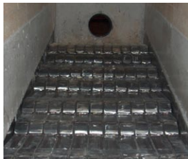
Podajnik paliwa z hydraulicznym podajnikiem skokowym
