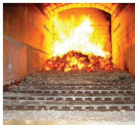
Wnętrze komory spalania
