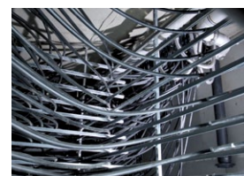
Instalacja do akumulacji lodu o pojemności 1800 m 3
