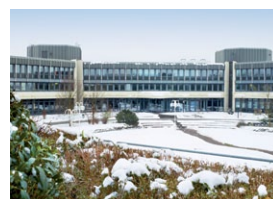
Budynek zarządu DGUV
