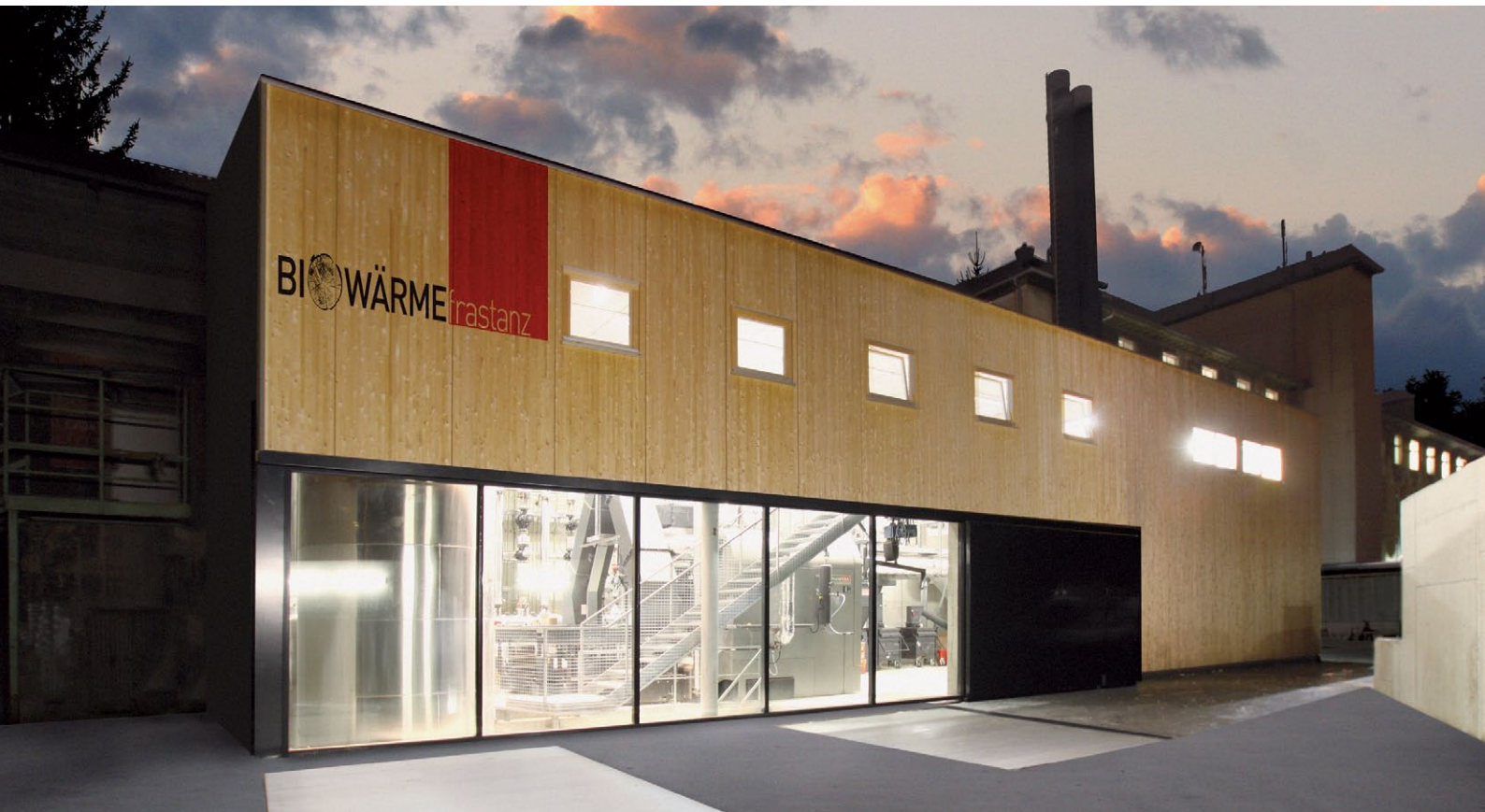
Ciepłownia wykorzystująca biomasę firmy E-Werke Frastanz, Austria
