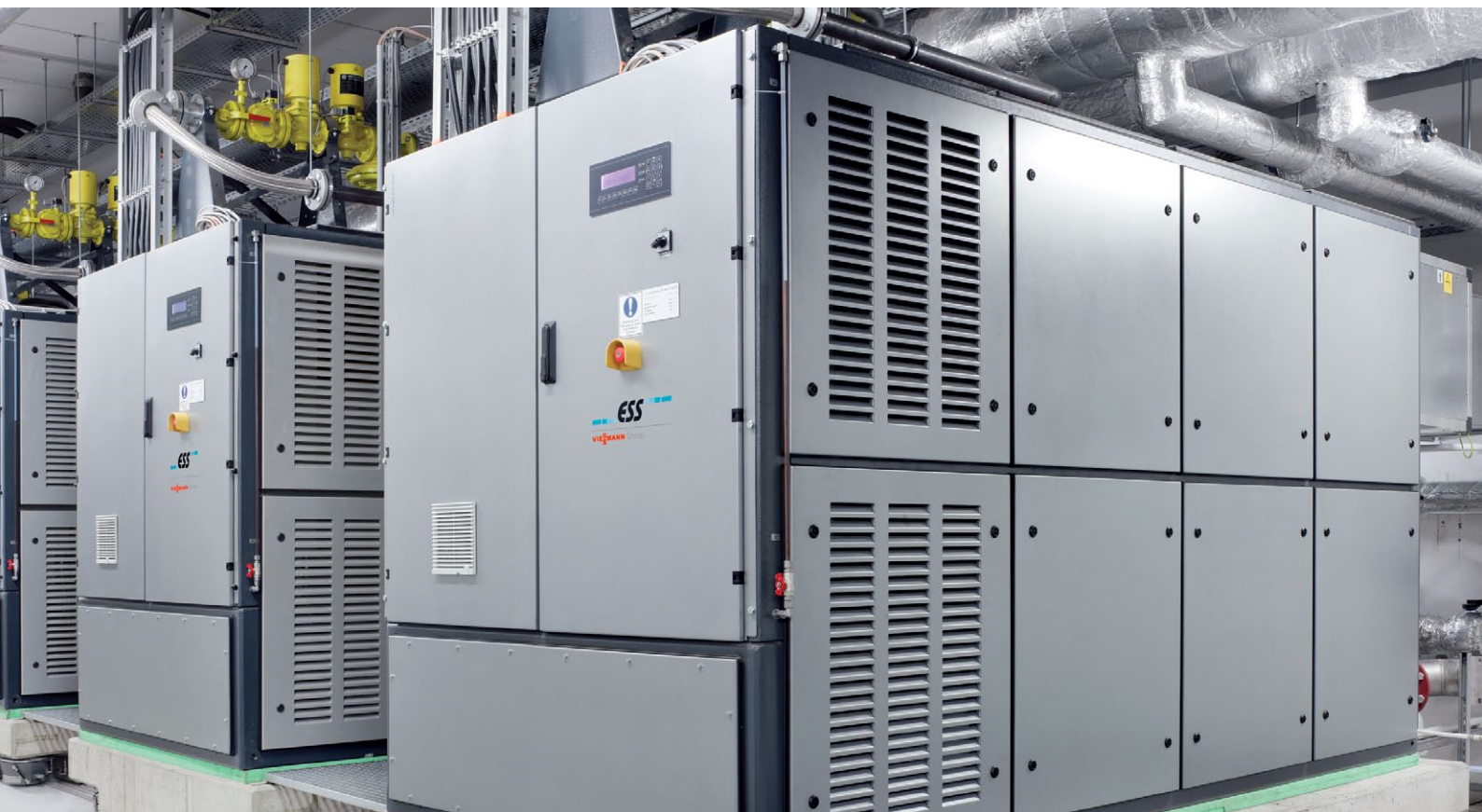
Centrala energetyczna DGUV z pięcioma agregatami kogeneracyjnymi w St. Augustin
