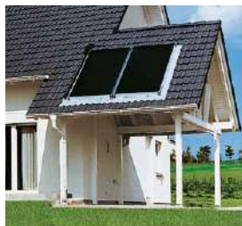
Vitosol 100-FM na dachu domu jednorodzinnego.
