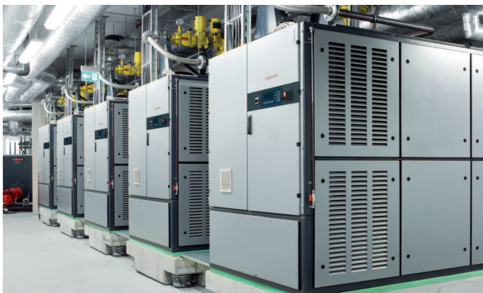
Pięć modułów kogeneracyjnych Vitobloc 200 w budynku administracyjnym niemieckiego ubezpieczyciela Deutsche Gesetzlichen Unfallversicherung
