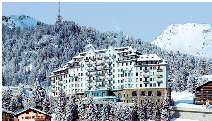
W pięciogwiazdkowym hotelu Ritz Carlton w St. Moritz ścieki wykorzystywane są do pozyskania ciepła do ponownego podgrzewu wody.
