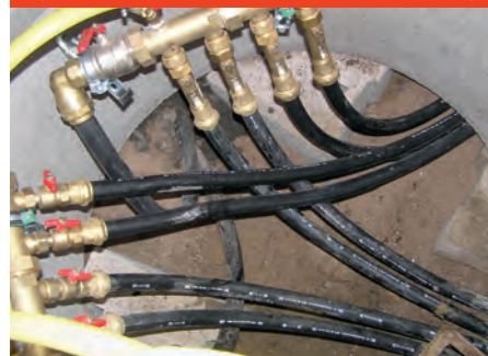
Rys. A.4.1–8 Rozdzielacz solanki w sondzie ziemnej
