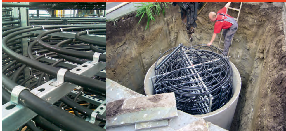
Rys. A.4.7–2 Zasobnik ciepła wykorzystujący przemianę fazową
