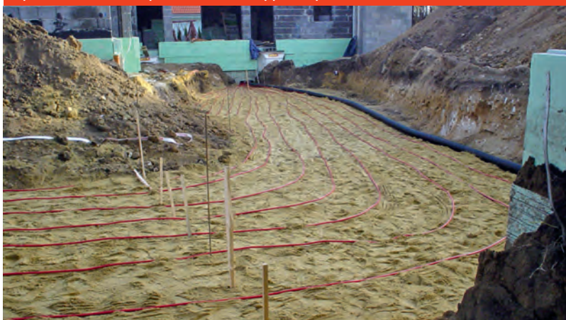
Rys. A.4.1–2 Źródło ciepła – kolektor ziemny poziomy
