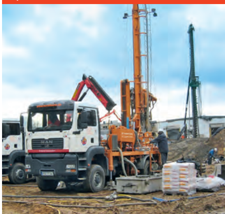
Rys. A.4.1-6 Prace wiertnicze
