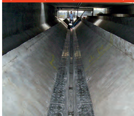
Rys. A.4.5-2 Wymiennik ciepła w kanale ściekowym
