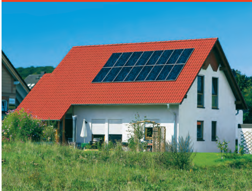
Rys. B.1.4-1 Instalacja fotowoltaiczna
