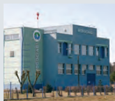
Miejskie Wodociągi i Oczyszczalnia, Grudziądz, Polska
