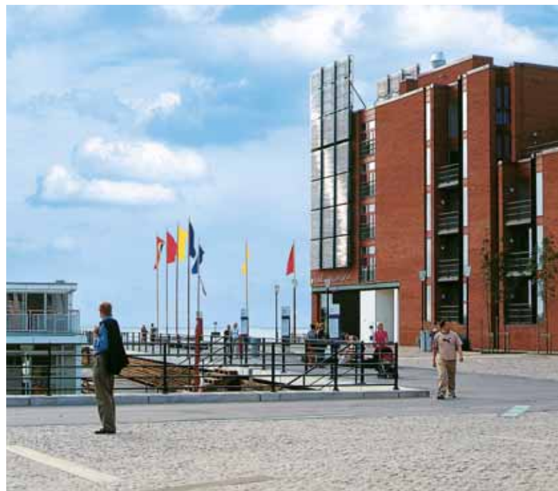
Fot. B.1.7–1 Kolektor próżniowy na fasadzie budynku w „mieście przyszłości”
