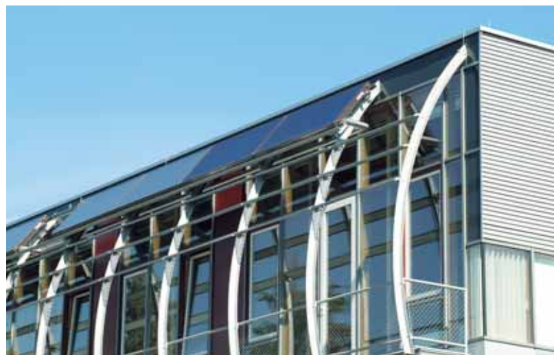
Fot. B.1.7–2 Montaż kolektorów jako roleta, baldachim
