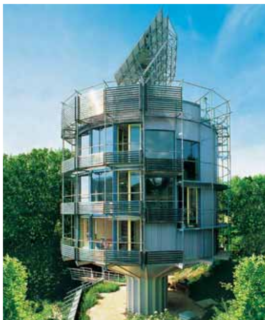
Fot. B.1.7–4 Kolektor próżniowy zamontowany na balustradzie w okrągłym domu w Freiburgu
